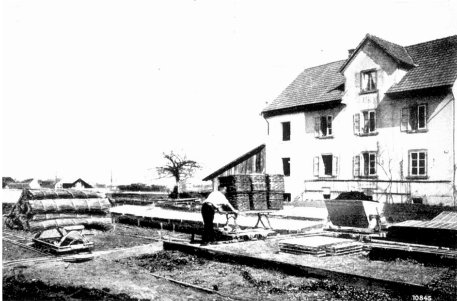
50- cm- Bahn für Handbetrieb in einer Gärtnerei um 1910. Als Fahrzeuge wurden hier leichte Kipperfahrgestelle verwendet, die mit einem erhöhten Ladetisch anstelle der Kippmulde versehen waren.
